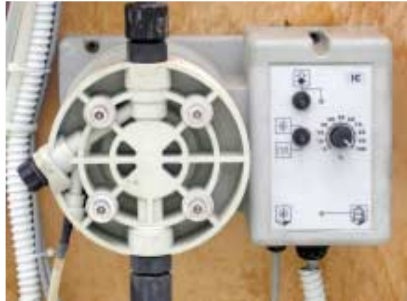
Pompa dosatrice elettrica a membrana. La pompa può essere utilizzata su impianti a controllo volumetrico o proporzionale. Si noti l'interruttore on/off e il regolatore della velocità di aspirazione
