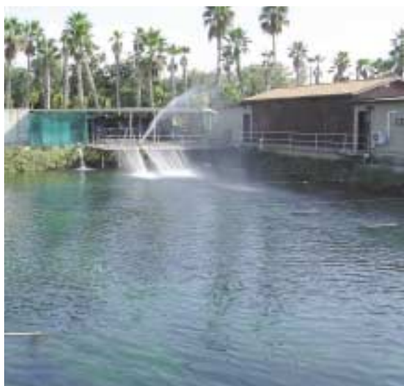
Bacino di raccolta delle acque di drenaggio
