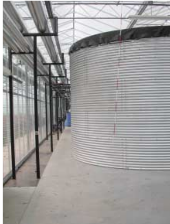
Deposito per la raccolta dell'acqua piovana in una serra di rose in Olanda. L'uso dei sistemi a ciclo chiuso è diffuso pressoché in tutte le serre olandesi e richiede dell'acqua irrigua di ottima qualità. Ciò spiega l'apparente paradosso dell'ampia diffusione dei sistemi di captazione dell'acqua piovana in una nazione che certamente non è afflitta dalla siccità
