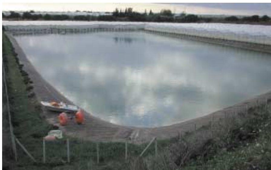
Enorme invaso per la raccolta dell'acqua piovana in un'azienda serricola in provincia di Ragusa
