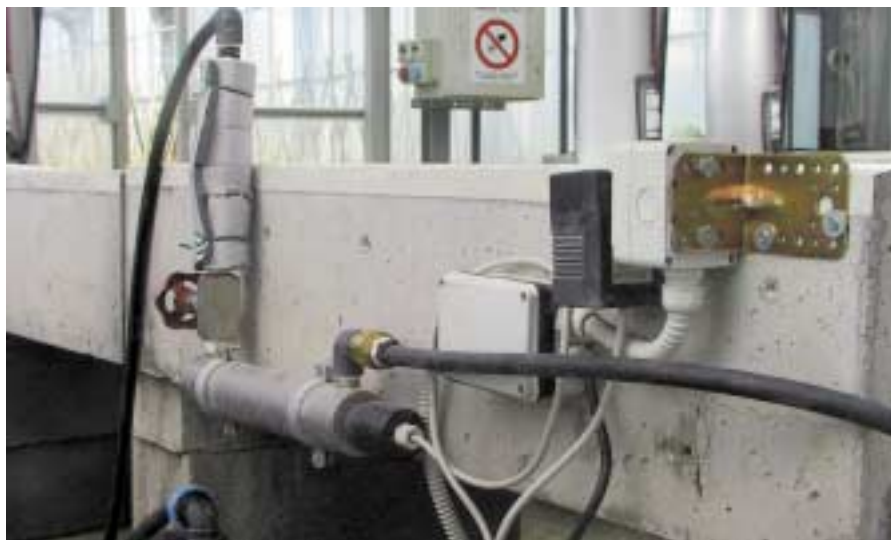
Un filtro a sabbia per impianti sperimentali di coltivazione idroponica
